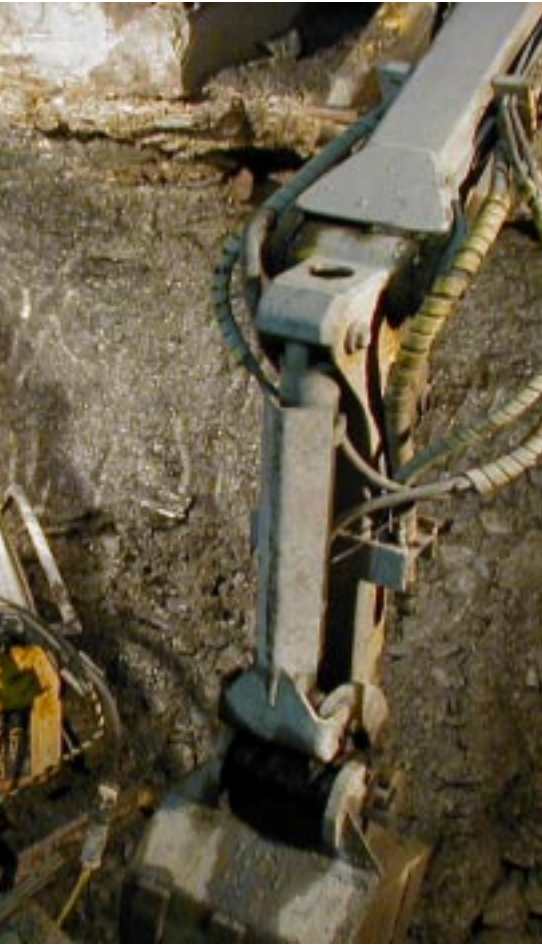
ut the debris.
